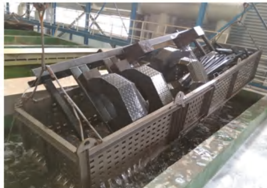
酸洗、硅烷前处理线
