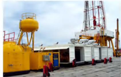
匈牙利 RG 石油公司项目 Project of RG Oil Company in Hungary
