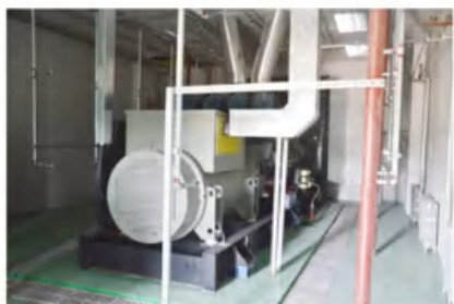
天津赛德数据中心项目 Tianjin saide data center project
